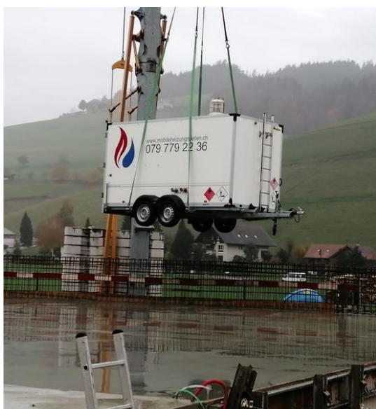
Anlieferung Notheizung 28. Okt. 2020
