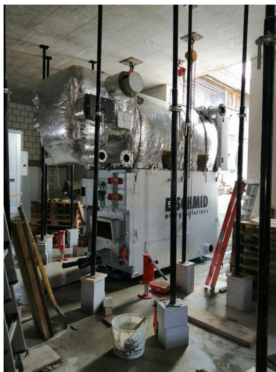
Anlieferung Ofen mit Kessel 6. Okt. 2020
