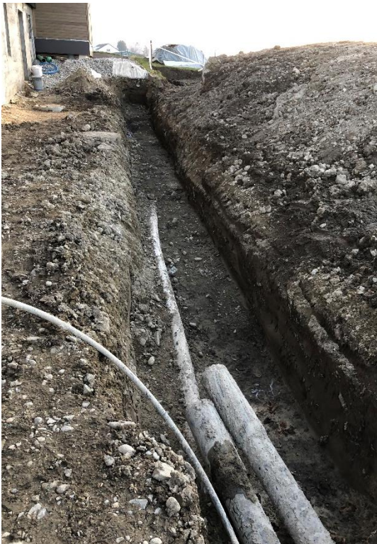
Leitungsbau Richtung Gewerbestrasse
