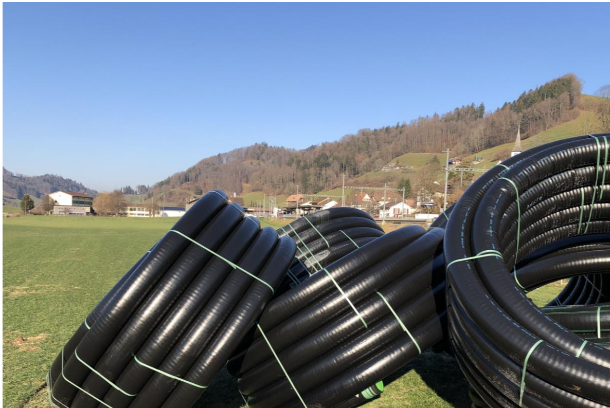
Fernwärmeleitungen bereit zum Einbau, Erschliessung zur Gewerbestrasse
